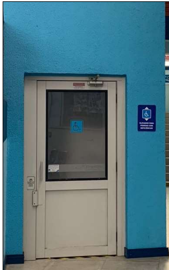
Figura 12 - Bloco A – Elevador acessível Fonte: Autor, 2022
