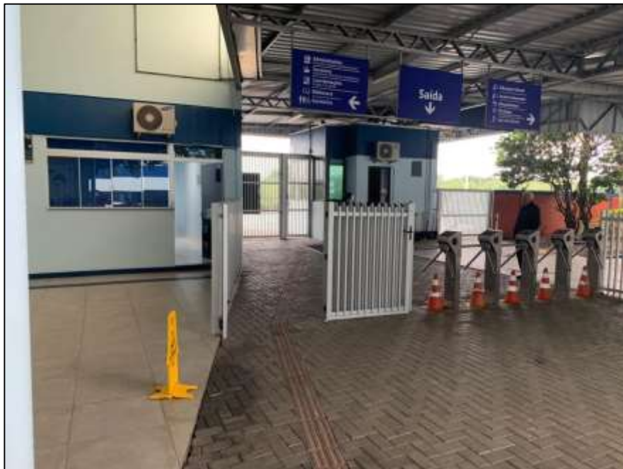
Figura 7 - Portão entrada pedestres Fonte: Autor, 2022
