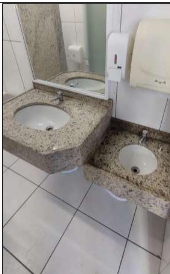
Figura 18 - Banheiro Acessível Fonte: Autor, 2022
