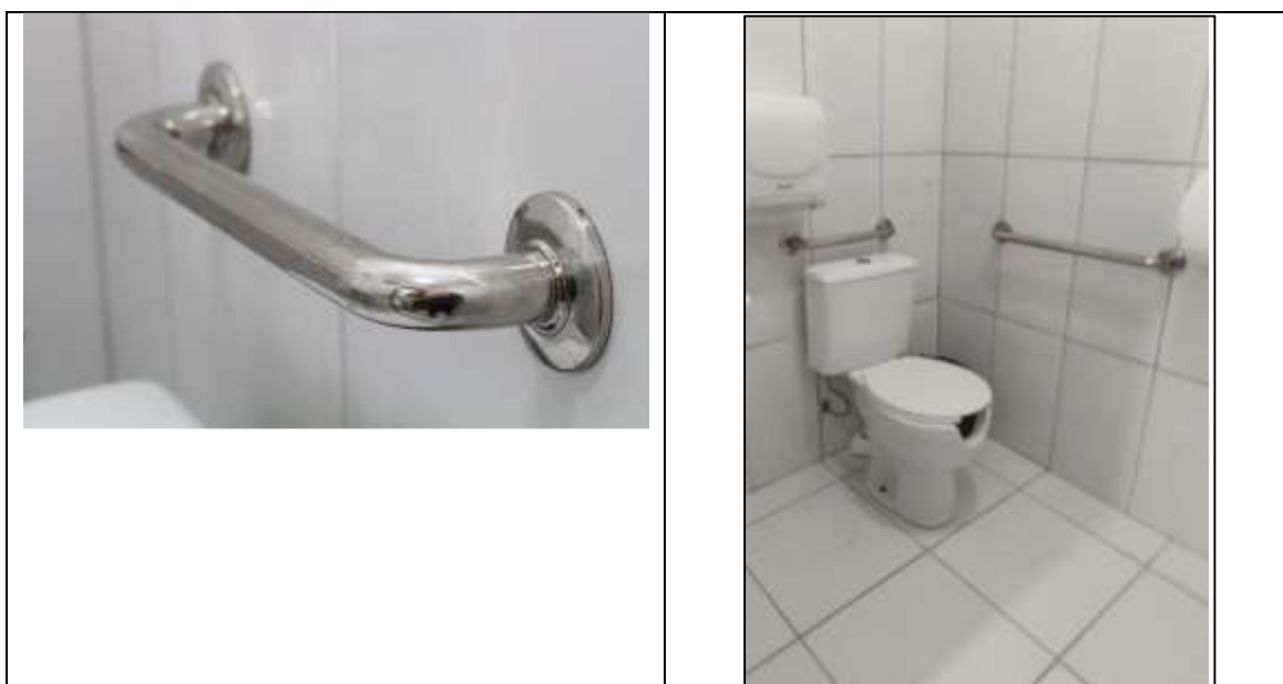
Figura 15 - Banheiro Acessível Fonte: Autor, 2022
